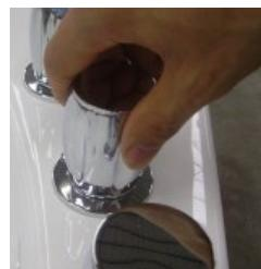
10. Вентиль горячей воды: откройте вентиль и отрегулируйте температуру горячей воды на выходе ручного душа или излива.
