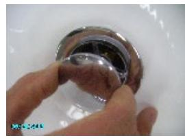
4. Настройка слива: отрегулируйте ход сливной пробки с помощью медного винта.
