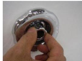
3. Очистка слива дренажа: выньте пробку и очистите сливное отверстие дренажной системы.
